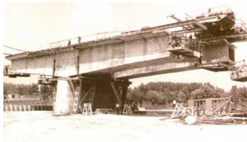
Kunszentmárton, első szabadon szerelt feszített vasbeton hidunk, 1975.
